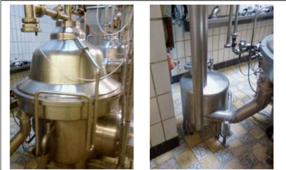
Abb. 12: Separator (links) und Auffangvorrichtung für Zentrifugenschlamm (rechts) Fotos: © LAVES
